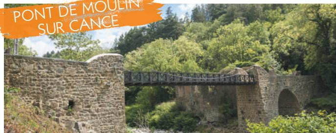
C'est l'inventeur annonnéen Marc Seguin qui a inventé la technique des ponts suspendus à câbles de fer. Ce pont est l'un des derniers ouvrages présents mettant en valeur son ingéniosité.
